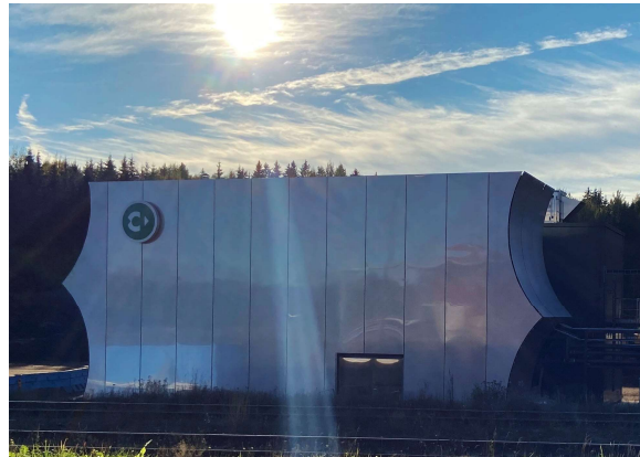
OxyPower HTC™ anläggningen vid Stora Ensos bruk i Heinola, Finland
